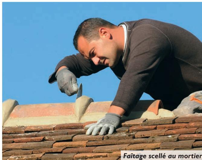
Faîtage scellé au mortier
