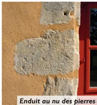
Dans la pratique, ces trois passes peuvent se limiter à deux, gobetis et corps d'enduit formant ensemble le « dégrossi ». Entre ces trois passes, il est nécessaire de laisser s'écouler un certain temps de séchage. Deux à trois jours au minimum entre les deux premières couches, jusqu'à sept jours pour la couche de finition.
