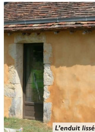
> L'enduit lissé, une fois projeté, est resserré avec le plat de la truelle. Il offre ainsi un aspect plus brillant qui présente de faibles ondulations de surface. Il acquiert aussi une plus grande dureté. C'est l'enduit traditionnel des maisons de village.
