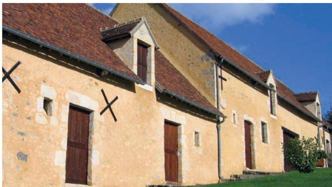
La lucarne traditionnelle du bâti rural se positionne au droit de la façade et non en milieu de toiture. Ses proportions sont toujours plus hautes que larges, en général dans un rapport de 1 x 1,5. Elle peut être en bois, c'est le cas le plus fréquent, ou à façade de pierre ou de briques.
